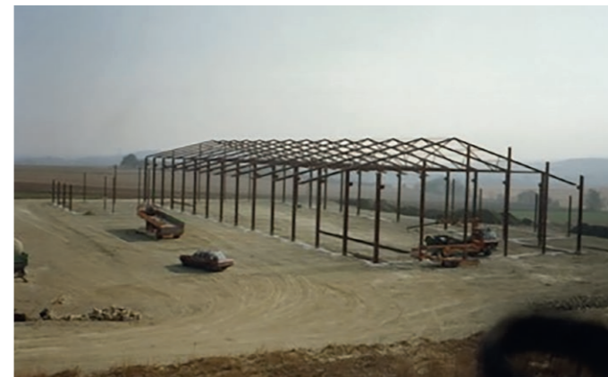
Der Rohbau der ersten Produktionshalle für Schwimmbecken entsteht Anfang der 1970er-Jahre.
