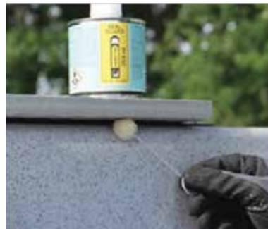
4. Optional: Für die bessere Haftung der Dichtmasse Seal Guard (Transparenter Primer) auftragen und ca. 15 Min. ablüften lassen.
