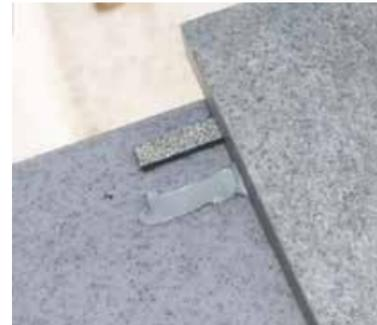
3. Steinplatte auflegen und leicht andrücken. Damit ist die Verklebung der Steinplatte abgeschlossen.
