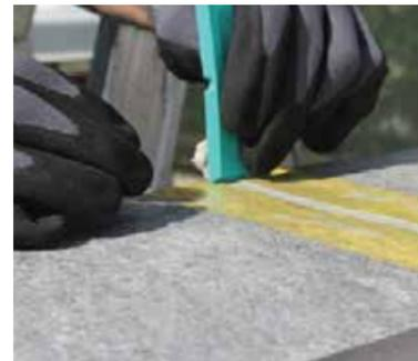
6. Abschließend die elastischen Fugen zwischen den Poolrandabdecksteinen und ggf. die anschließende Fuge zu einer weiteren Steinreihe mit Easy Seal XS (Universelle Polymer-Dichtmasse) verfugen/ausfüllen und abziehen.
