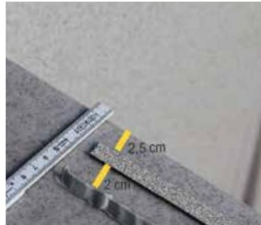
2. PE-Entkoppelungsband mit einem Abstand von 2,5 cm zum inneren Beckenrand anbringen. In einem weiteren Abstand von 2 cm Adheseal (Streichbare Klebedichtmasse) mit Kartuschen-Spitzen auftragen.
