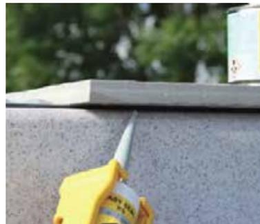
5. Danach die Schattenfuge (Spalt zwischen Becken und Steinplatte) mit Easy Seal XS (Universelle Polymer-Dichtmasse) verfugen/ausfüllen. Seal Fluid als Glättmittel verwenden und mit Fugenspachtel-Set abziehen.
